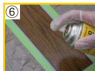
⑥ 平滑になったことを確認しラッカーズプレーもしくはアクリルスプレーで艶調整を行って下さい。
