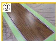
③ ウルトラリムーバーで汚れや油分を除去し、養生シートで養生して下さい。
