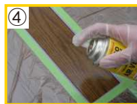
④ サンジグシラーズプレーをキズ周辺にスプレーします。
