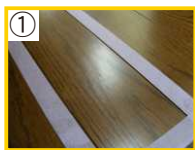
① 養生テープを張り、ピースで見切ります。
