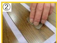
② キズを中心にサンドペーパーで目粗しして下さい。
