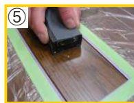
⑤ 表面の乾燥後、水を含ませたサンドペーパー（#400～800）で研磨して下さい。
